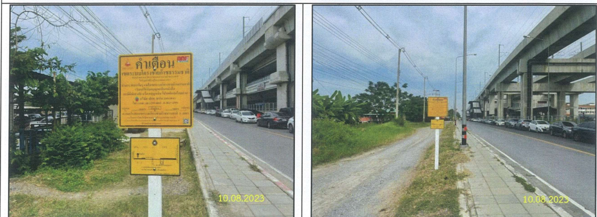
ข) การติดตั้งป้ายเตือนแสดงตำแหน่งแนววางท่อส่งก๊าซธรรมชาติ และหมายเลขโทรศัพท์ในการแจ้งเหตุฉุกเฉิน (โทร 1540)
